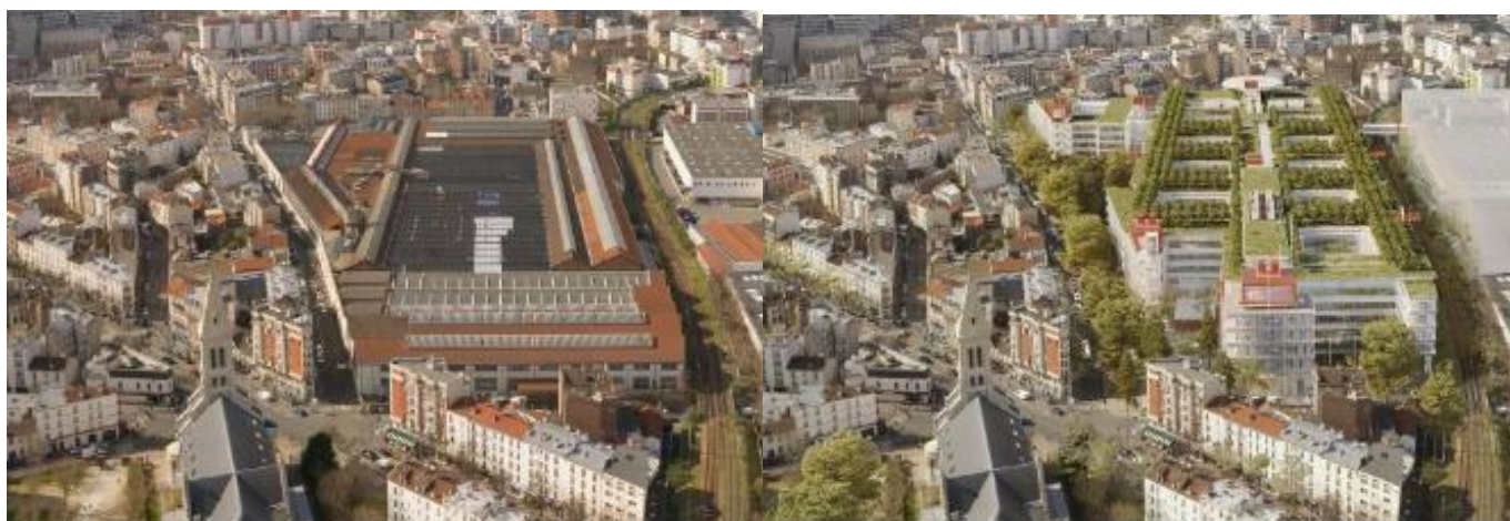
Usine état ACTUEL – vue d'ensemble
